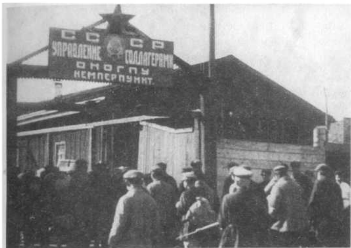
Кемь. Пересыльный пункт
